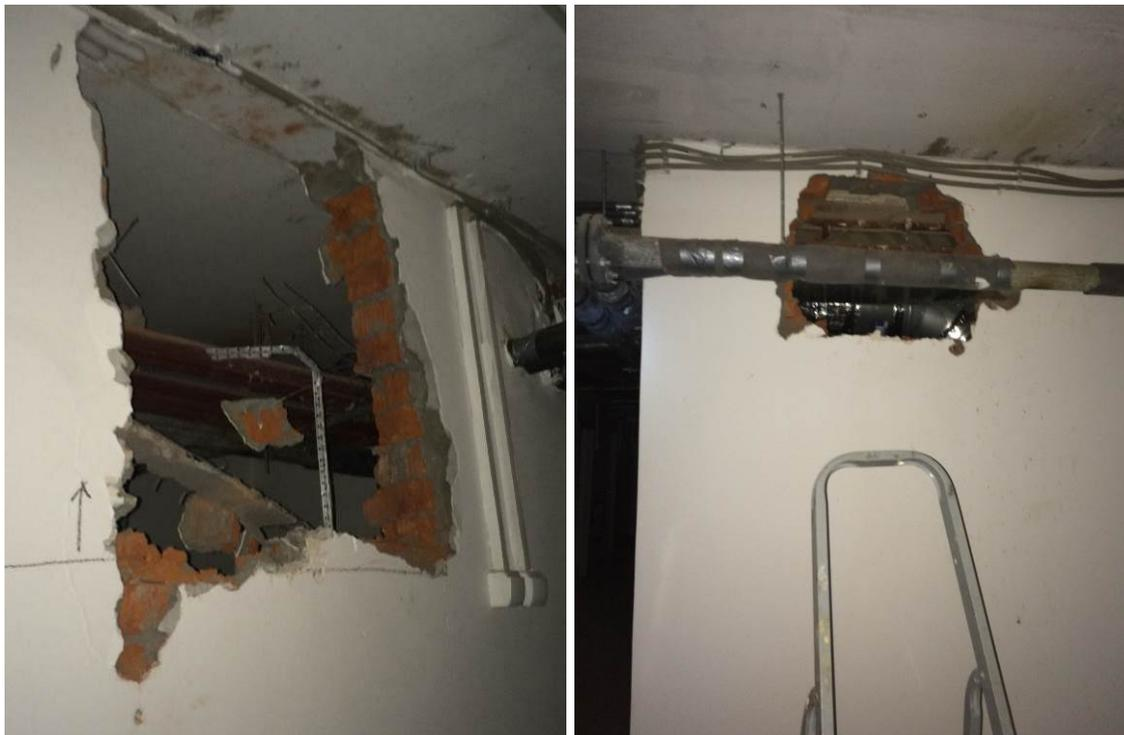
**Рис. П. 1.2 – Примеры зондирования каменных конструкций**
