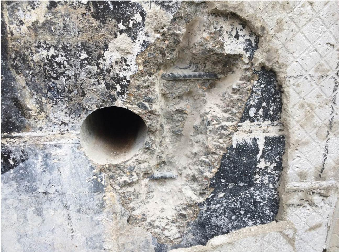
**Рис. П. 1.4 – Пример зондирования железобетонных конструкций**
