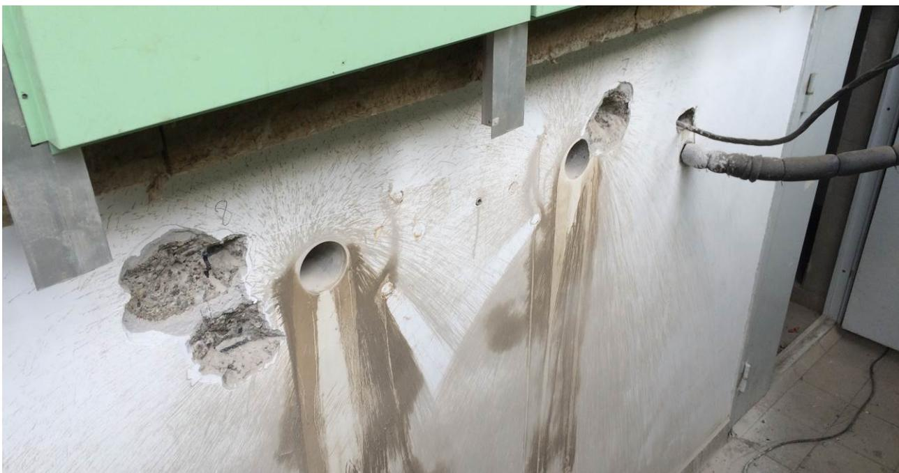
**Рис. П. 1.1 – Пример зондирования железобетонных конструкций**
