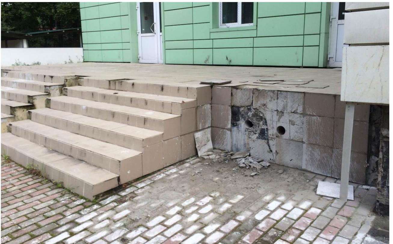
**Рис. П. 1.5 – Пример зондирования железобетонных конструкций**
