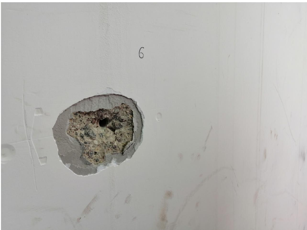
**Рис. П. 1.3 – Пример зондирования железобетонных конструкций**
